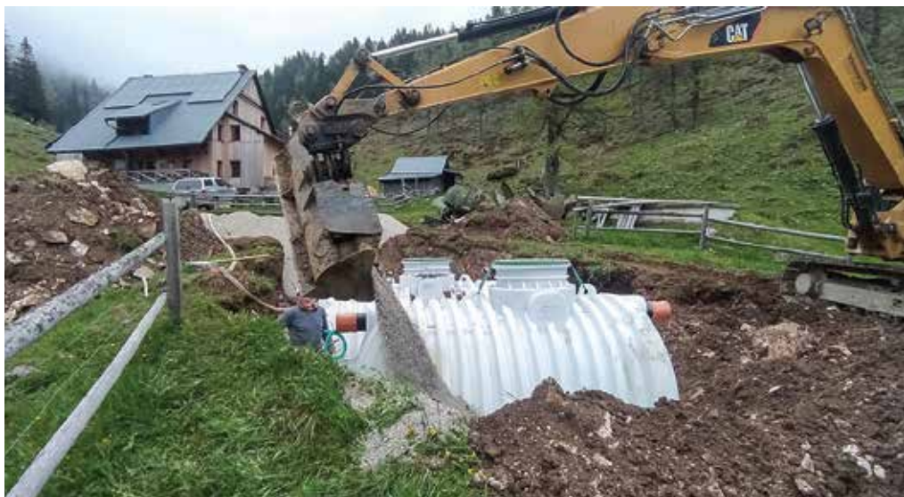
Vgradnja nove čistilne na Koči na Loki
