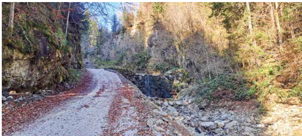
Cesta ob potoku Lakovnik po končanih obnovitvenih delih
