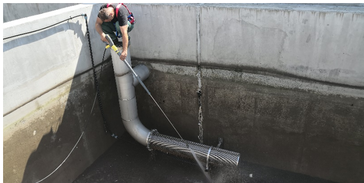
Slika 1: Že očiščeno desno sito. Spodnji del sita se zaradi nedostopnosti ne da očistiti.
